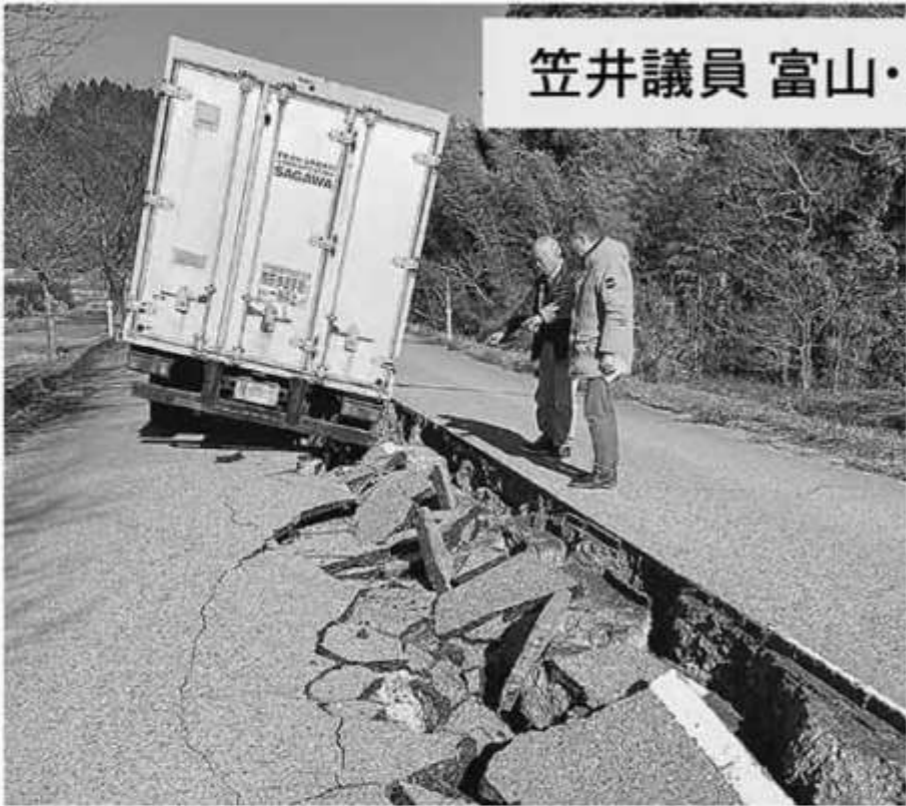
地震で亀裂の入った道路にはまるトラックを見る笠井議員(右) 2日、富山県氷見市内
