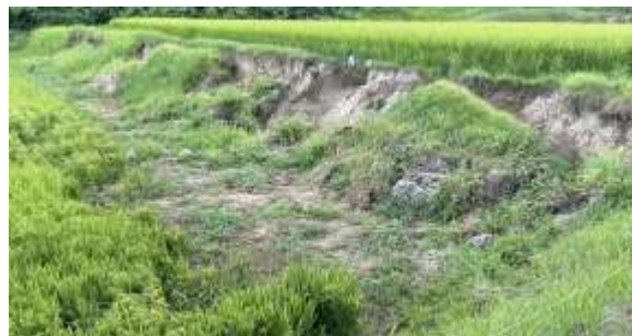
水田の畦が崩れている=8月6日
